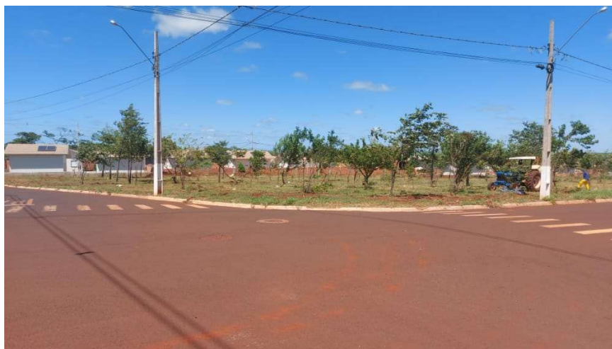
8. VISÃO TOTAL DO TERRENO. CONJUNTO HABITACIONAL FLORINEA "E" – JARDIM SÃO JOSÉ AO FUNDO – 22/12/2022
