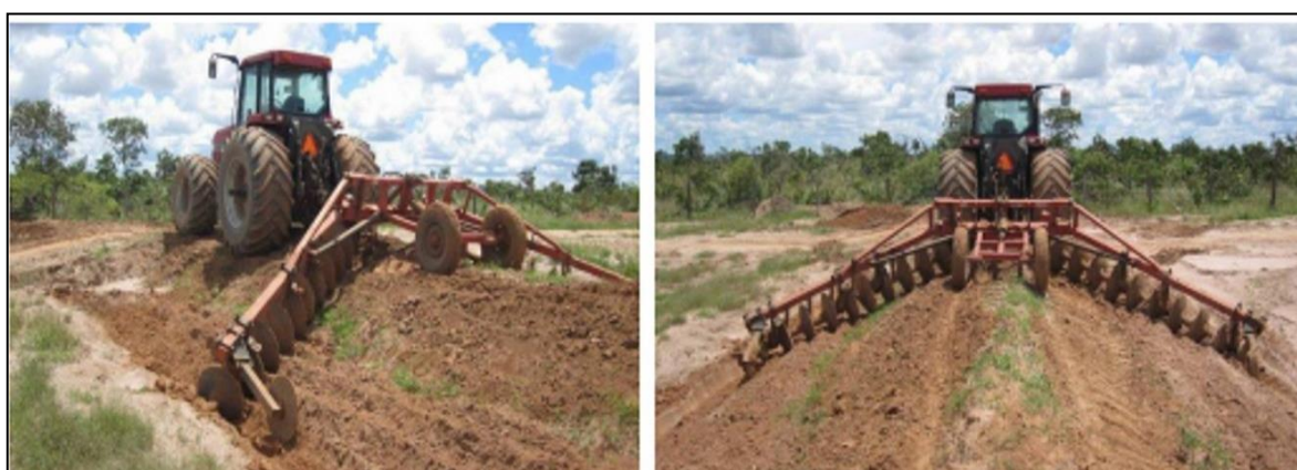
Figura 52 - Construção de terraço de base larga com arado terraceador
