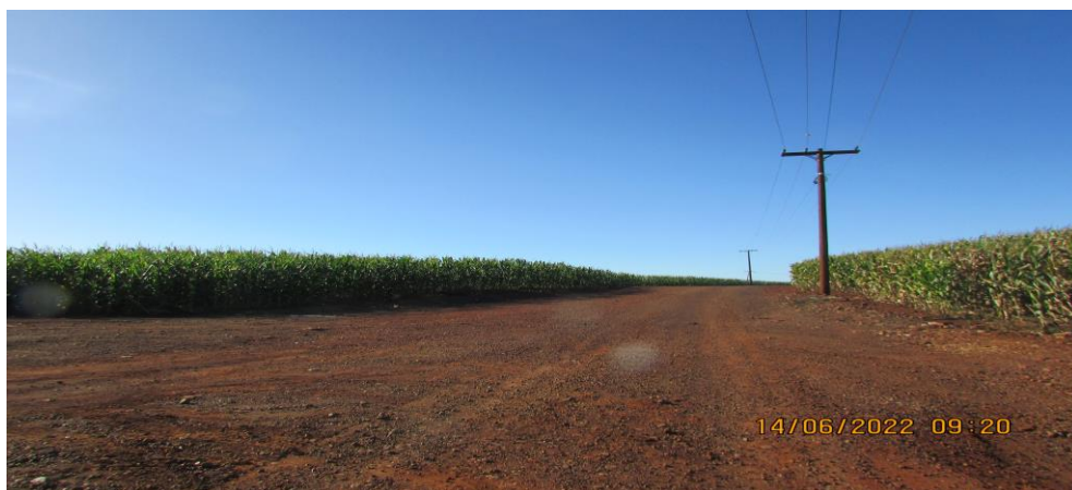
Figura 24 – Trecho inicial da estrada sem revestimento.
