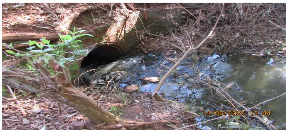
Figura 28 – Tubulação de concreto.
